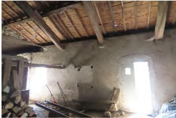
Le plafond dans la grange est composé d'une charpente en bois recouverte de lattes et des tuiles précédemment décrites. A noter de nombreuses traces d'humidité.
