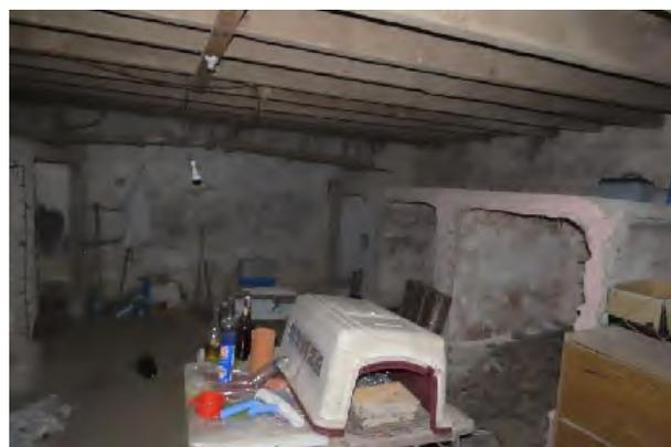
Le plafond est composé de la sous face d'un plancher soutenu par des poutres en bois apparentes.
