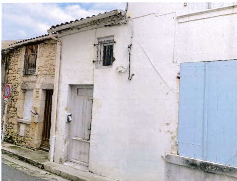
Façade rue Rose (Ouest) :
